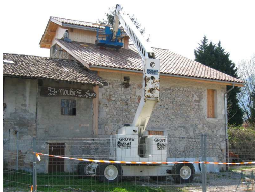
Pose de bardage sur le moulin des Ayes
