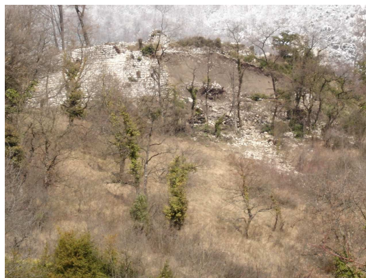
L'éboulement du rempart le 15 mars 06
