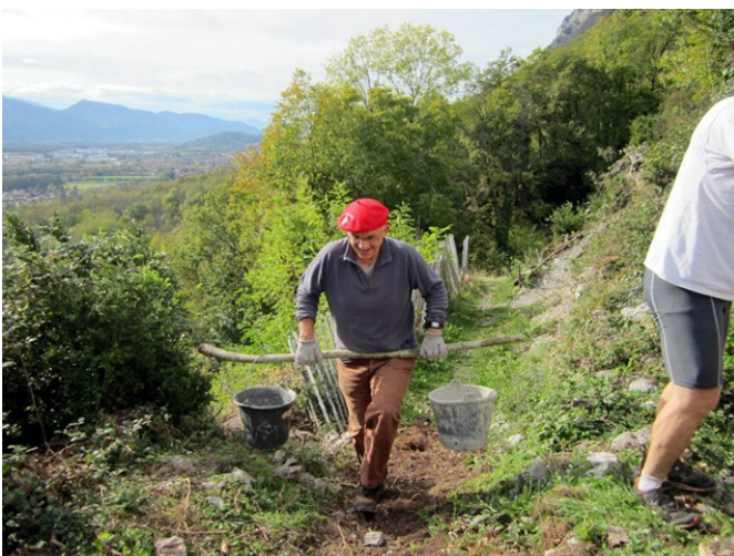
Gérard en porteur sherpa monte au pied de l'enceinte le ravitaillement en mortier
