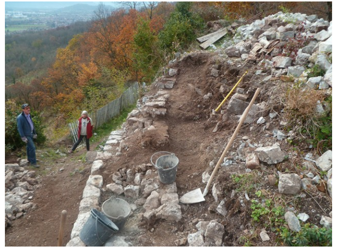
La forme incurvée du mur et la largeur avec le parement intérieur est bien visible sur cette photo. On constate le léger virage de l'enceinte. Le niveau médiéval, constaté par la présence d'un léger voile de sable et des casseroles de tuile est au niveau de la pelle.
