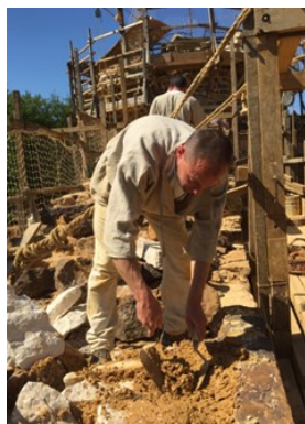
La maçonnerie, admirez les échafaudages, la roue monte-charge, le mortier à la chaux et la pierre noire de Guédelon
