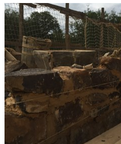
La maçonnerie, admirez les échafaudages, la roue monte-charge, le mortier à la chaux et la pierre noire de Guédelon
