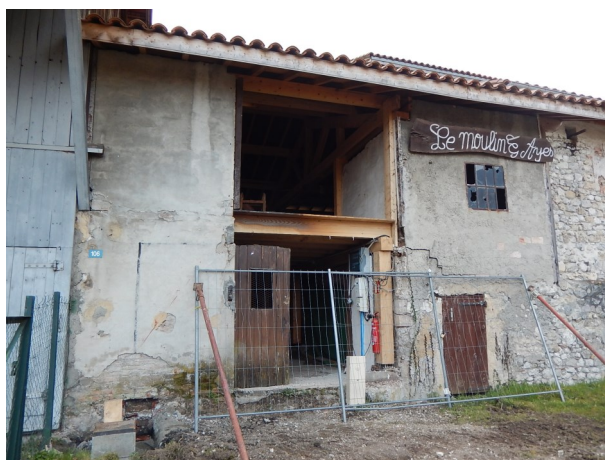
Début des travaux sur la façade au moulin
