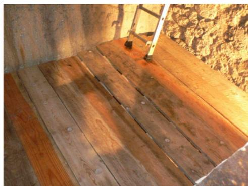
Une des faces de la roue n'était plus accessible car de petites cloisons avaient été installées pour boucher les ouvertures permettant de faire la maintenance de la face cachée de la roue. Ces cloisons ont été démolies, ce qui a entraîné une augmentation très forte de l'humidité dans le moulin. Afin de réduire cette humidité, nous avons réalisé des volets tels qu'ils devaient être à l'origine du moulin.
