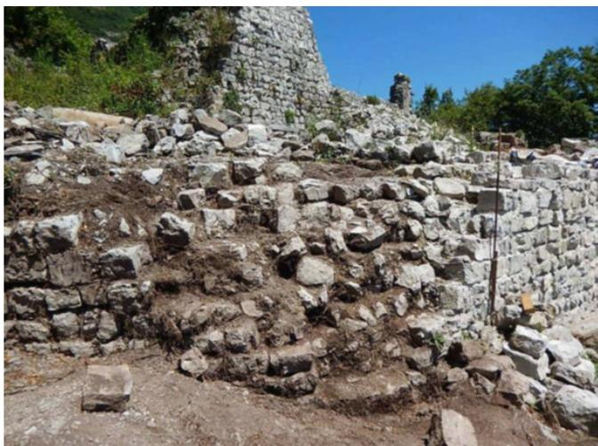
Il nous a fallu quelques gâchées pour consolider la 2<sup>ème</sup> enceinte jusqu'au début de la courbure : 3 rangs de parement remontés de chaque côté et comblement entre les deux sur près d'1 mètre de large.
