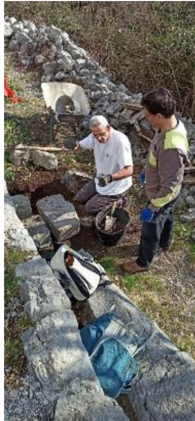
Remplacement de l'escalier bois par de solides pierres,
